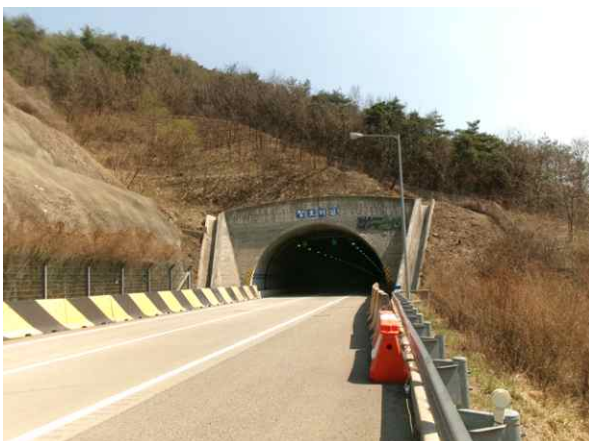
4공구 평호터널(영천방향) (4공구) 시점부
