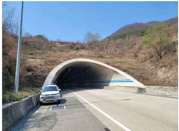
3공구 군위터널(영천방향) (3공구) 종점부
