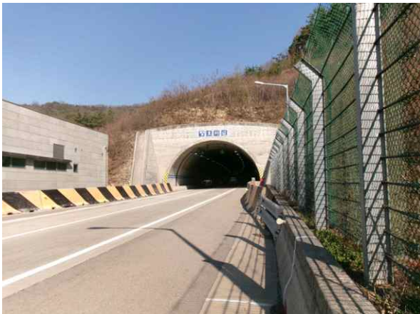
4공구 평호터널(상주방향) (4공구) 시점부
