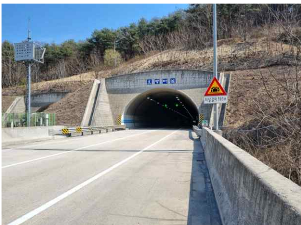
5공구 효령터널(영천방향) (5공구) 시점부
