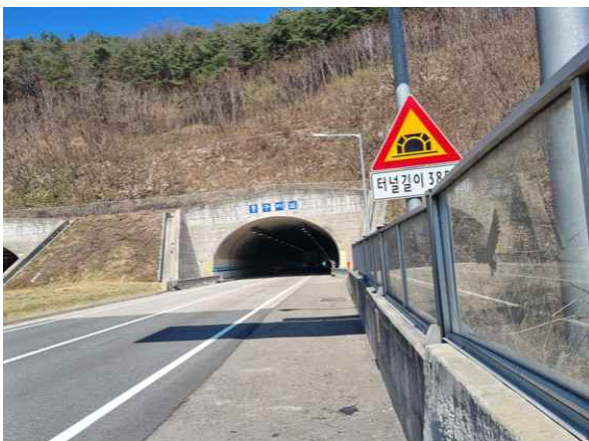
5공구 중구터널(상주방향) (5공구) 시점부
