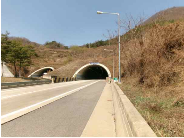
3공구 군위터널(상주방향) (3공구) 시점부
