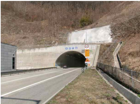
5공구 효령터널(상주방향) (5공구) 시점부
