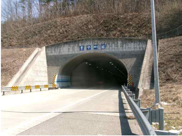
5공구 중구터널(영천방향) (5공구) 시점부
