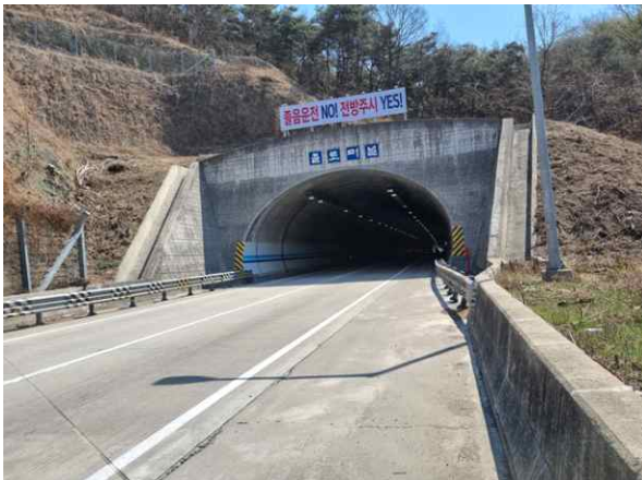
5공구 불로터널(영천방향) (5공구) 시점부
