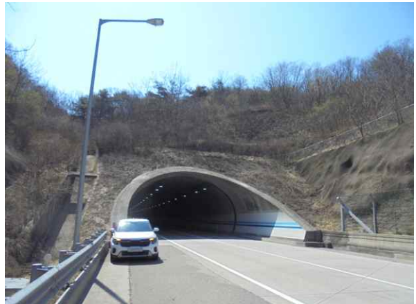
4공구 산법터널(상주방향) (4공구) 종점부
