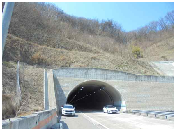
5공구 효령터널(영천방향) (5공구) 종점부
