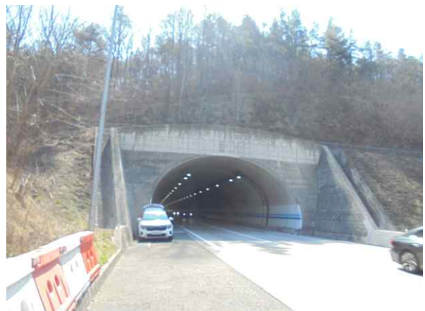
5공구 중구터널(상주방향) (5공구) 종점부
