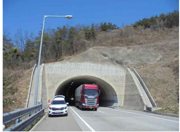
4공구 산법터널(영천방향) (4공구) 종점부
