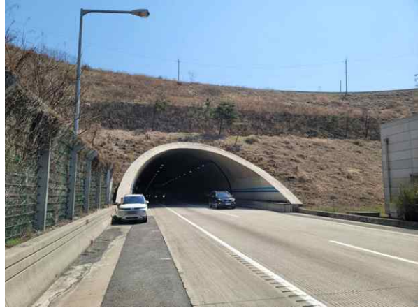
3공구 군위터널(상주방향) (3공구) 종점부
