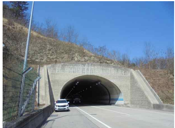
5공구 불로터널(영천방향) (5공구) 종점부
