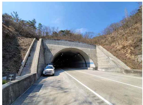
4공구 평호터널(영천방향) (4공구) 종점부
