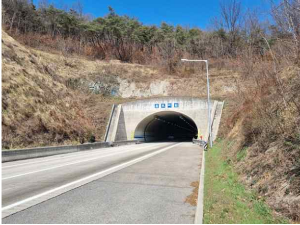
5공구 불로터널(상주방향) (5공구) 시점부
