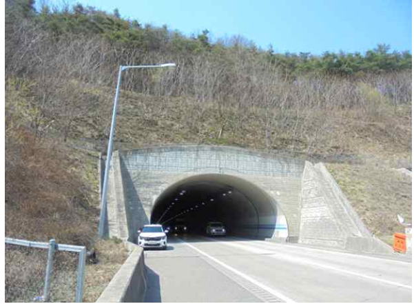
5공구 중구터널(영천방향) (5공구) 종점부
