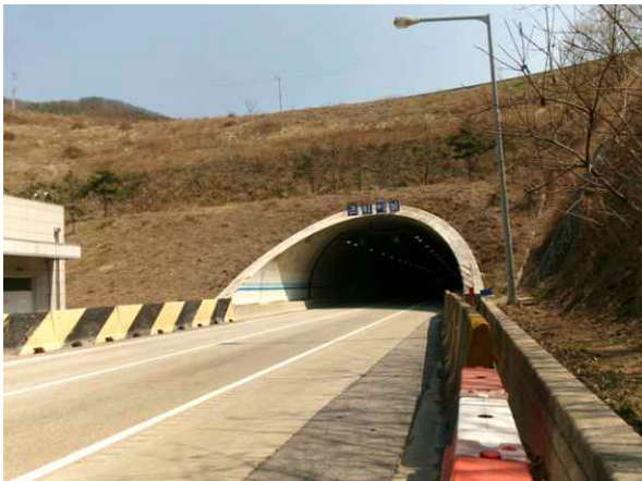
3공구 군위터널(영천방향) (3공구) 시점부
