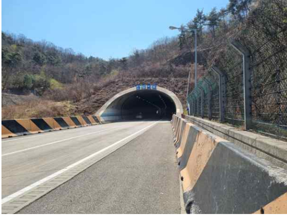
4공구 산법터널(영천방향) (4공구) 시점부
