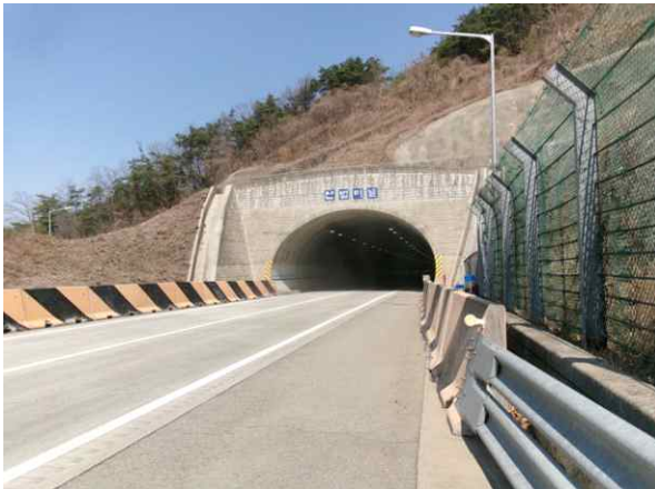
4공구 산법터널(상주방향) (4공구) 시점부
