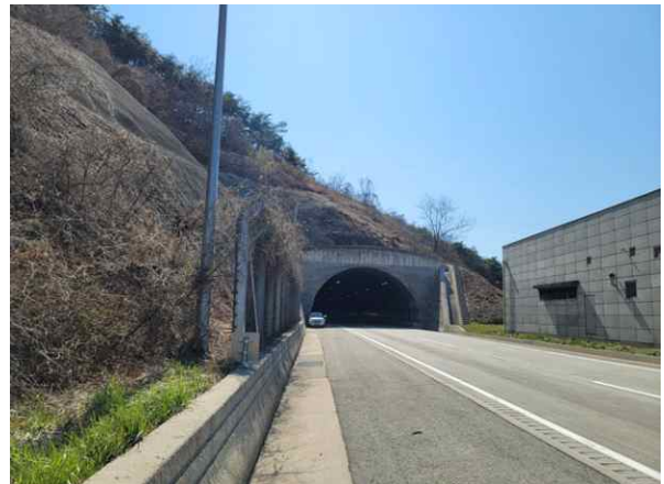
4공구 평호터널(상주방향) (4공구) 종점부
