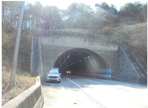
5공구 효령터널(상주방향) (5공구) 종점부
